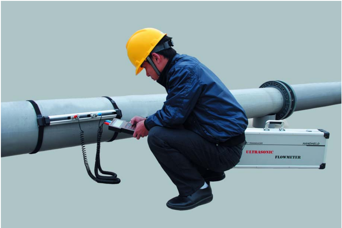
图 1.水平管道安装支架传感器
